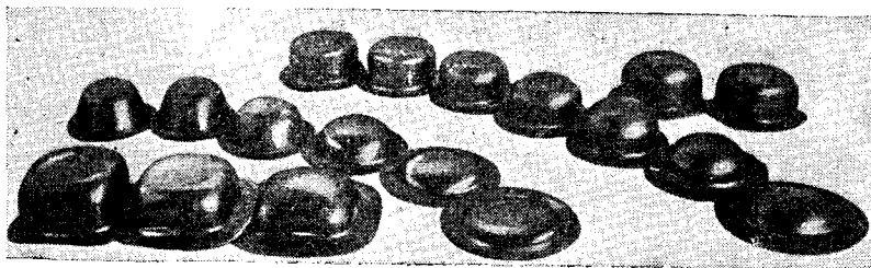
Фиг. 119. Последовательные стадии гидравлической вытяжки.
